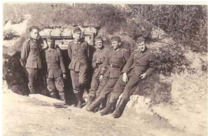
Foto (li) Rückseite: „Auf B. Stelle bei Rshew im Herbst 1942 - Olt Stehle, 471. IR; OWMst Hümmerlein; Uffz ...“ (B = Beobachtungs-Bunker) Foto (re): Ein Unterstand der 471.IR bei Kischkino.
