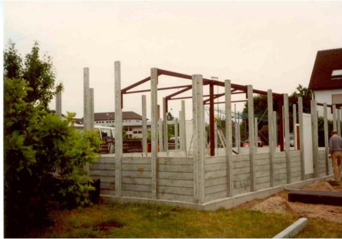
Jetzt standen noch die Stützen im Aufenthaltsraum im Weg! (re) Die 3. (hinterste) wurde abgesägt und der Querträger verstärkt, an der 2. bot sich der Anbau einer Taschen- und Sitzkissen-Ablage an und die 1. verschwand in der Küchen-Rigips-Wand.
